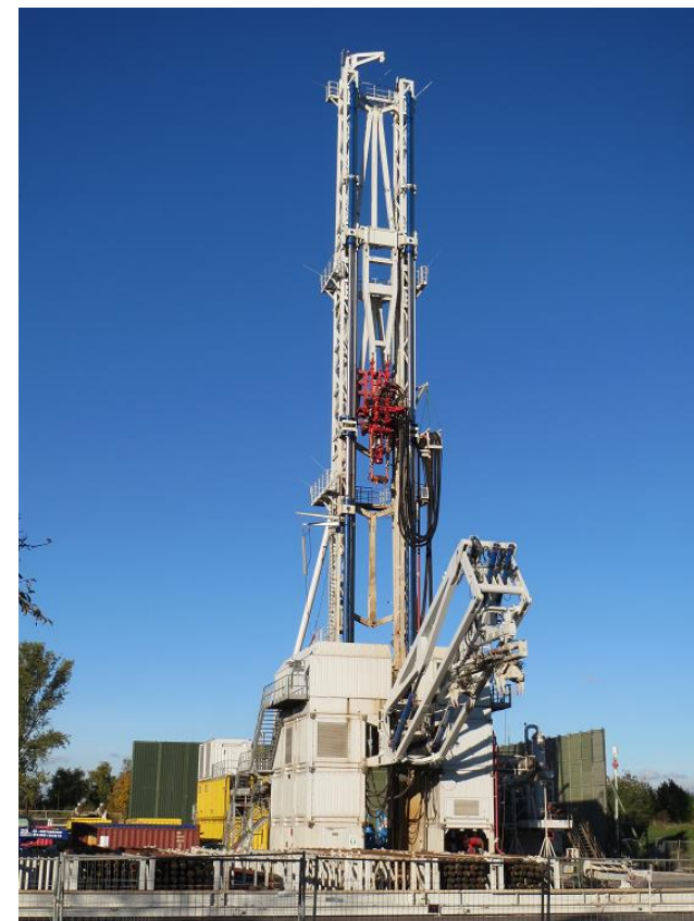
Boorinstallatie voor een geothermiebron
