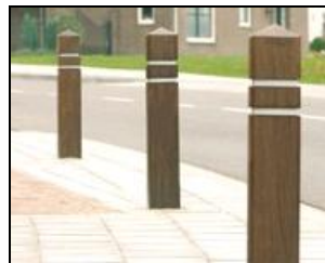
Figuur 16 Zelfde product, in ander materiaal uitgevoerd (links hardhout, midden hardhout nagemaakt met recycalaat en rechts betonnen paaltje nagemaakt uit recycalaat)
