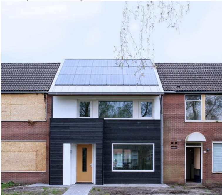
Figuur 4 0-op-de-meter woning: combinatie van isolatie en elektrificatie
