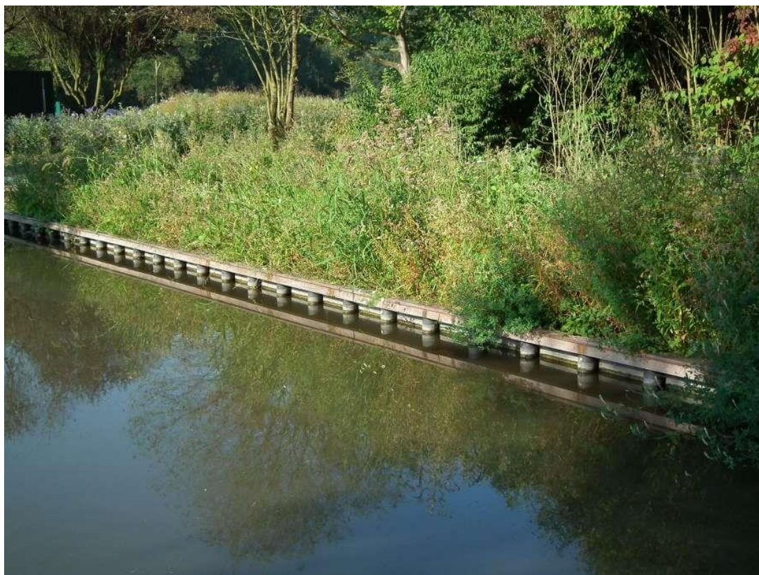
Figuur 2 - Beschoeiingselement van hout en gerecycled kunststof
