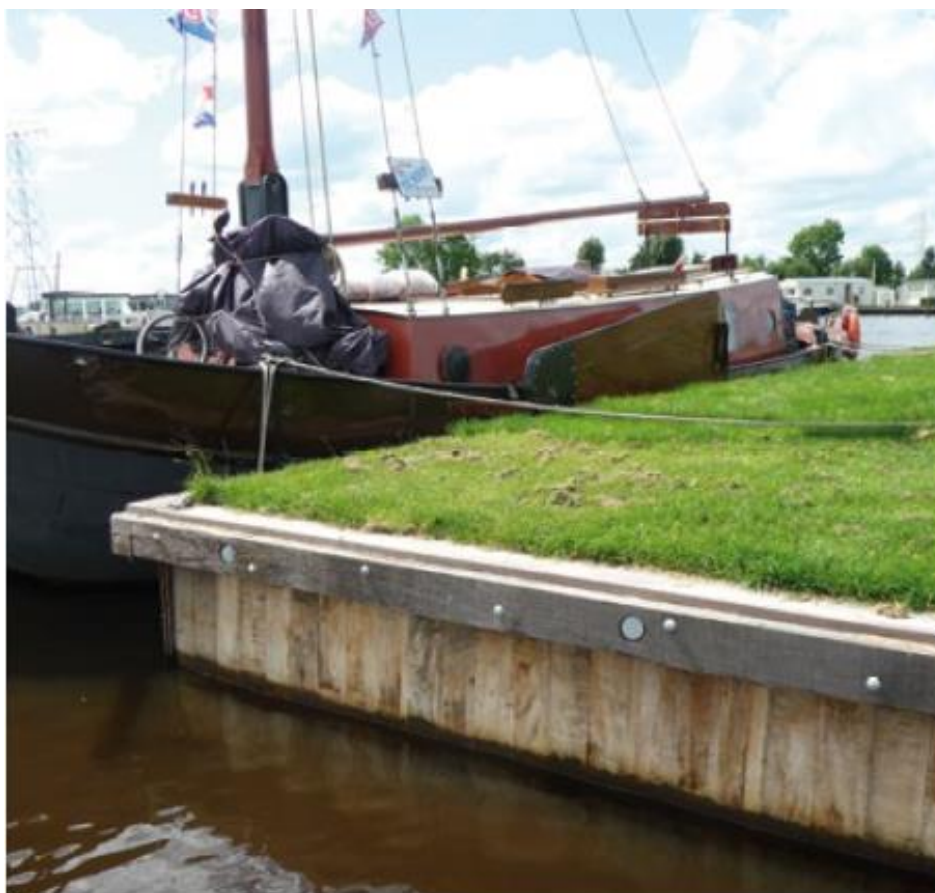
Figuur 2 - Damwand van Europees hardhout
