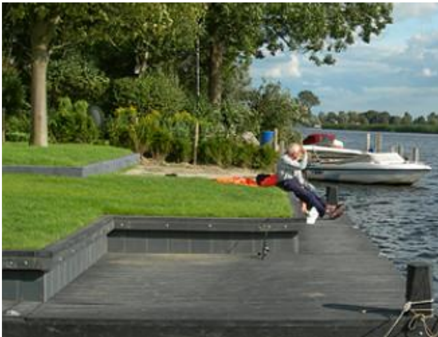
Figuur 2 - Damwand van gerecycled kunststof
