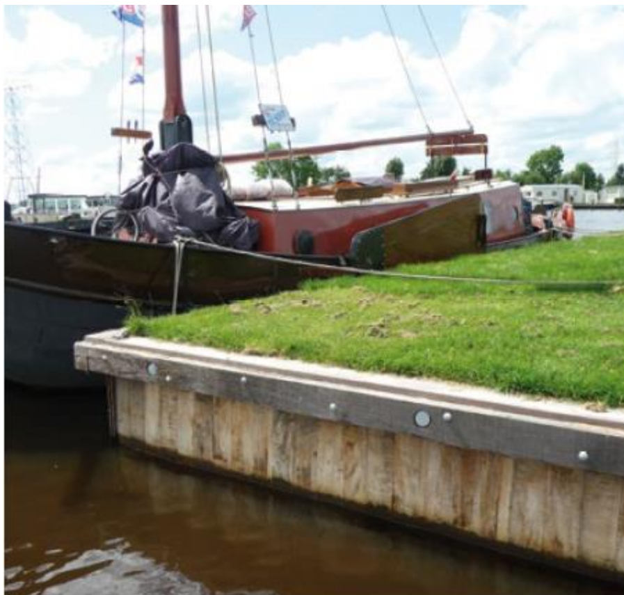
Figuur 2 - Damwand (tropisch) hardhout
