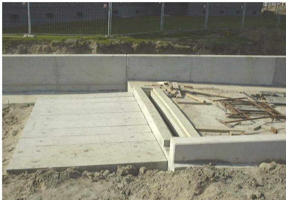
Figuur 3 - Stootplaat van beton
