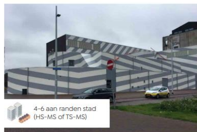
TS-MS station (van 25-66 naar 3-23 kV)
