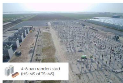
HS-MS station (van 110-150 naar 3-23 kV)
