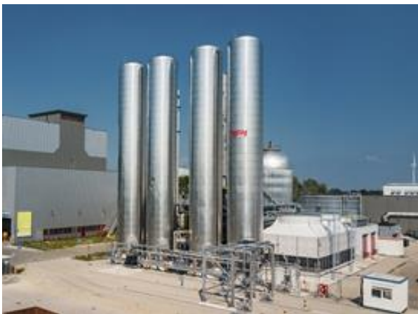
Figuur 2.3 Voorbeeld van een waskolom op rookgas Bron: website AVR
