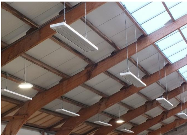
Figuur 4 - Infraroodpanelen in bedrijfshallen
