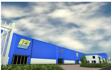
Buig Centrale Steenbergen - Hoogeveen
