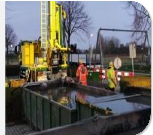
Aanboring van één van de MTO-bronnen in Groningen
